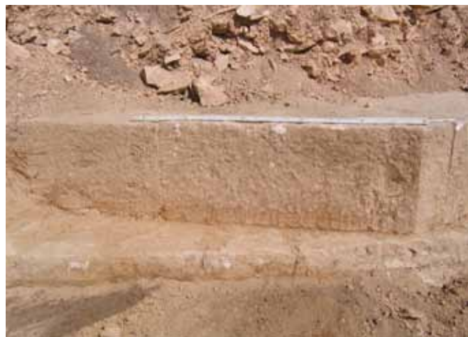
ill. 4. Moyen appareil : tour de la Casernette. (Photo : R Pellé)
