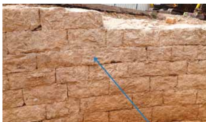
ill. 7. Moellons taillés en arrondi à la tour n°2 du Préventorium (fouilles 2014 R Pellé).
