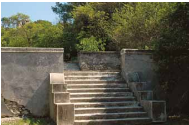
Sur le mont Cavalier Escaliers construits à proximité des remparts
