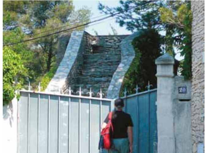
Rempart aménagé dans une propriété privée (au nord de la tour Magne)
